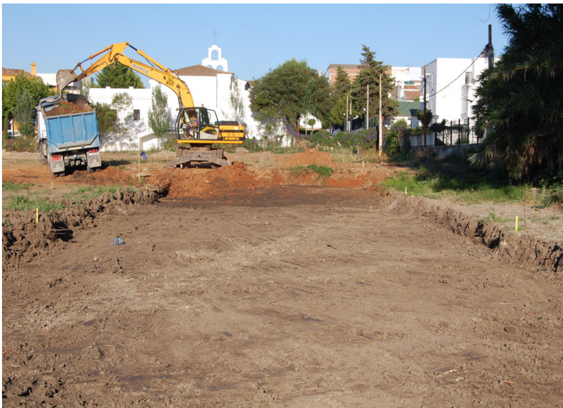
Lámina 4. Vista de los trabajos en el sector de la UE 003.
