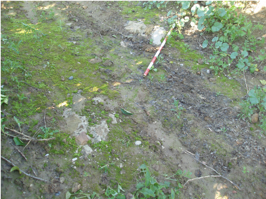
Lámina 2. Vista del muro de mampostería.
