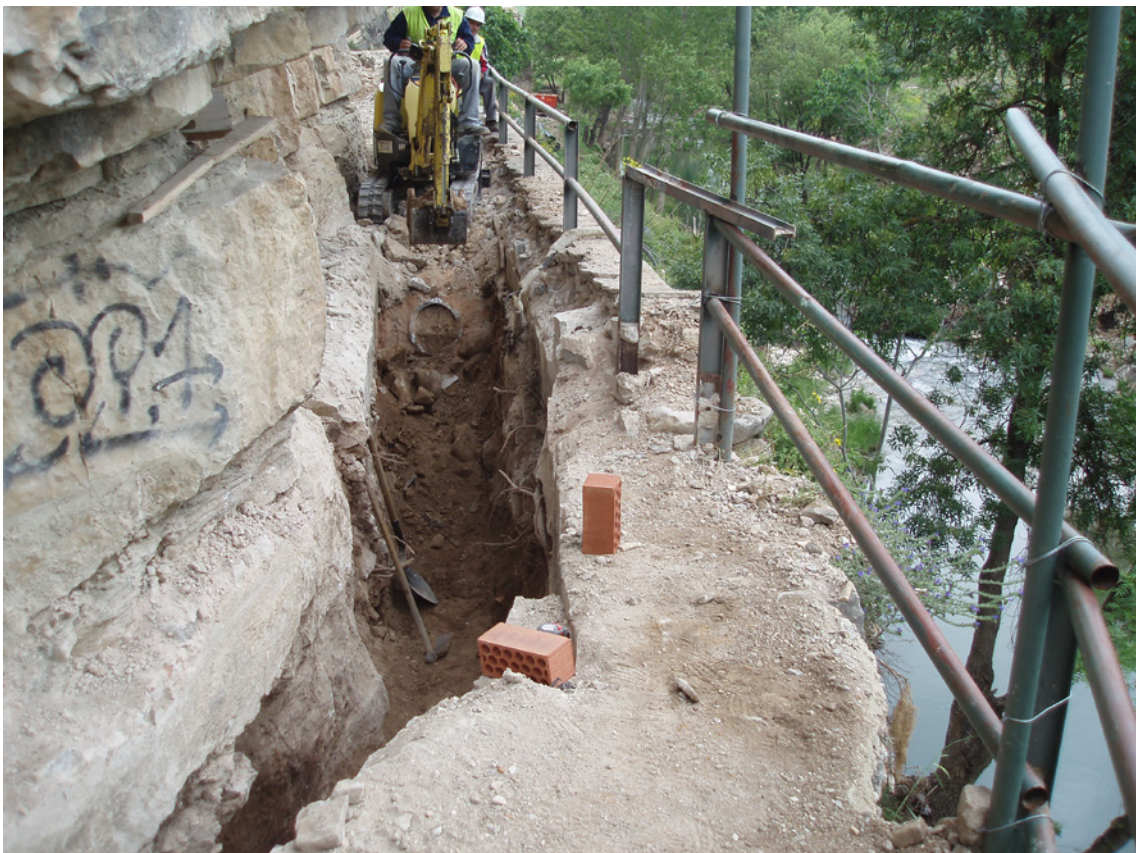
Lámina 2. Trabajos de vaciado del interior de la acequia.
