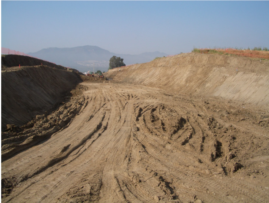
Fotografía 2: Desmonte de la loma entre el aeropuerto y el río.
