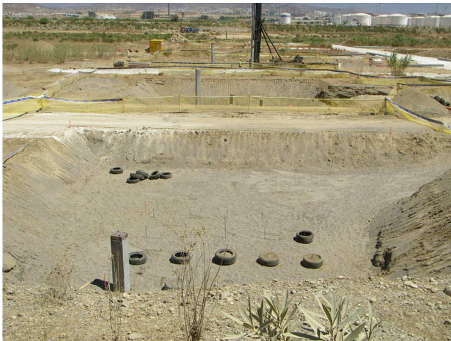
Fotografía 3: Vista de las pilas para cimentar el puente.
