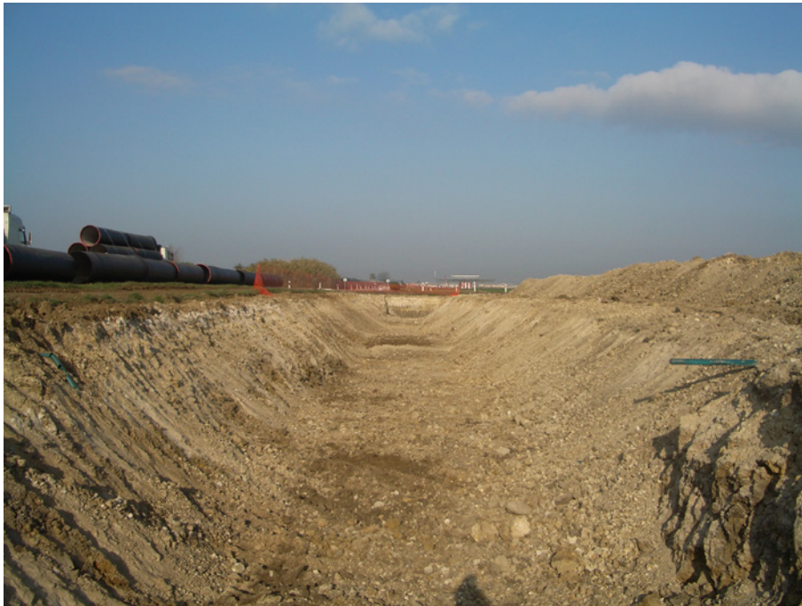
Fotografía 1: Zanja en el interior del aeropuerto.
