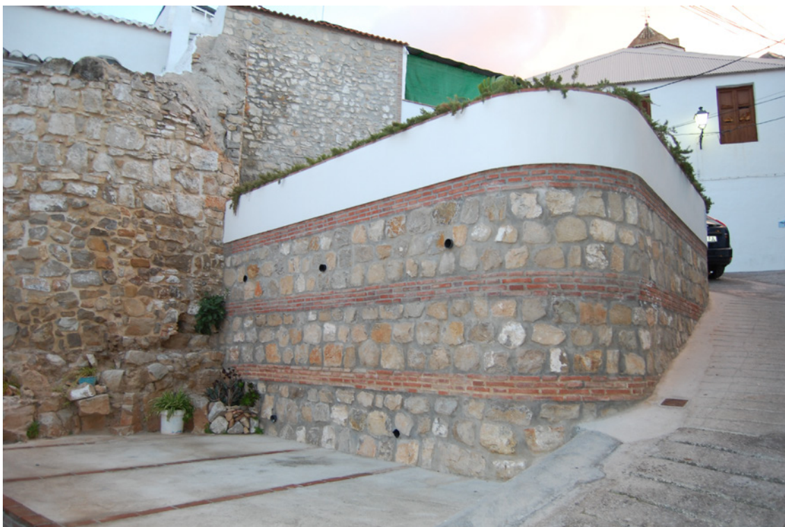
Lámina 1. Vista preliminar del solar.
