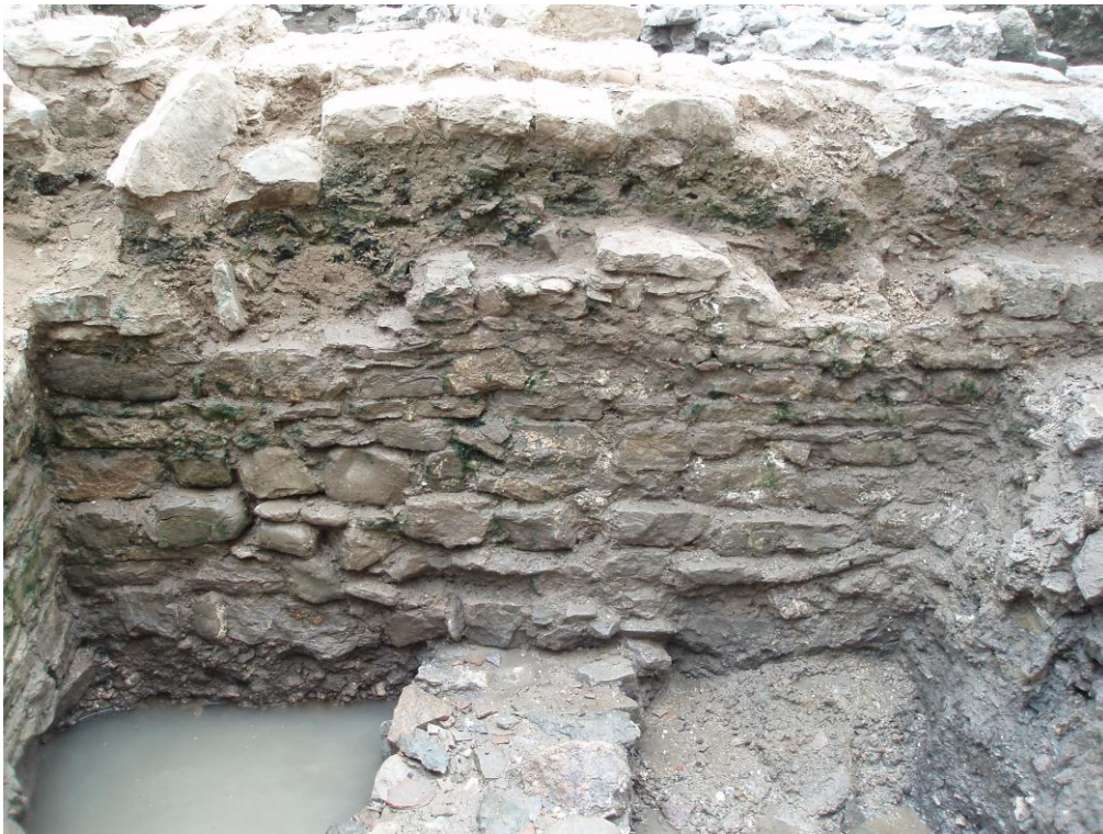
Lámina 3: Detalle de cimentación amortizando el muro del siglo XI.
