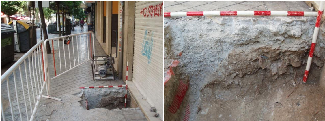
Lámina 5 y 6. Arqueta 2 y perfil estratigráfico en la calle Ancha de Capuchinos.
