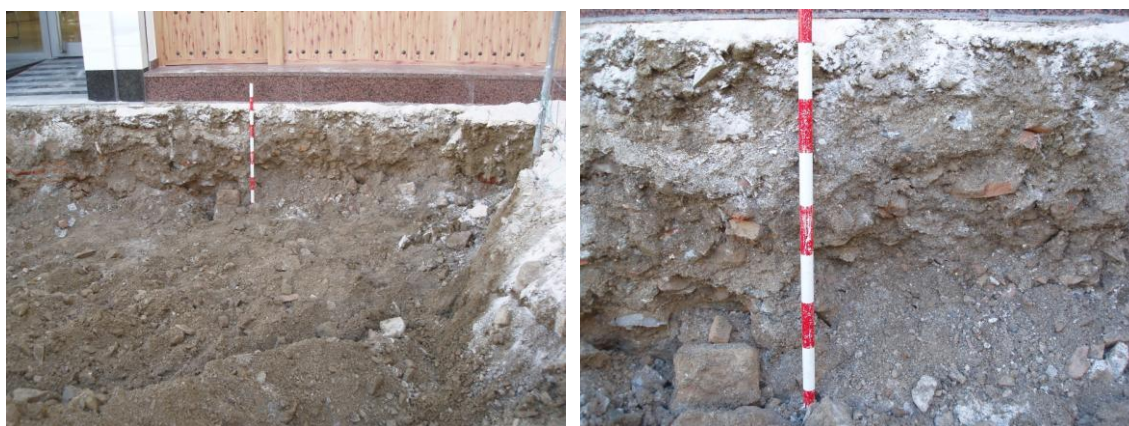
Lámina 5 y 6. Tramo 2 de la zanja y perfil en el lateral Este de la plaza.
