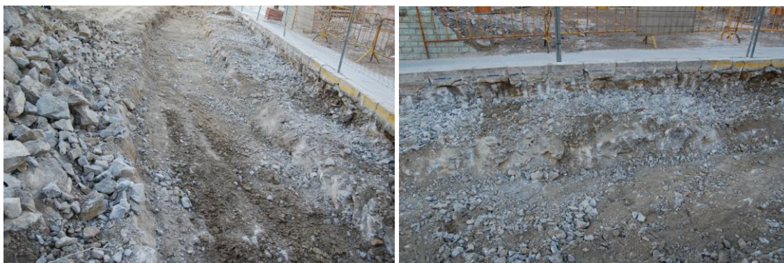
Lámina 3 y 4. Tramo 1 de la zanja y perfil en el lateral Norte de la plaza.
