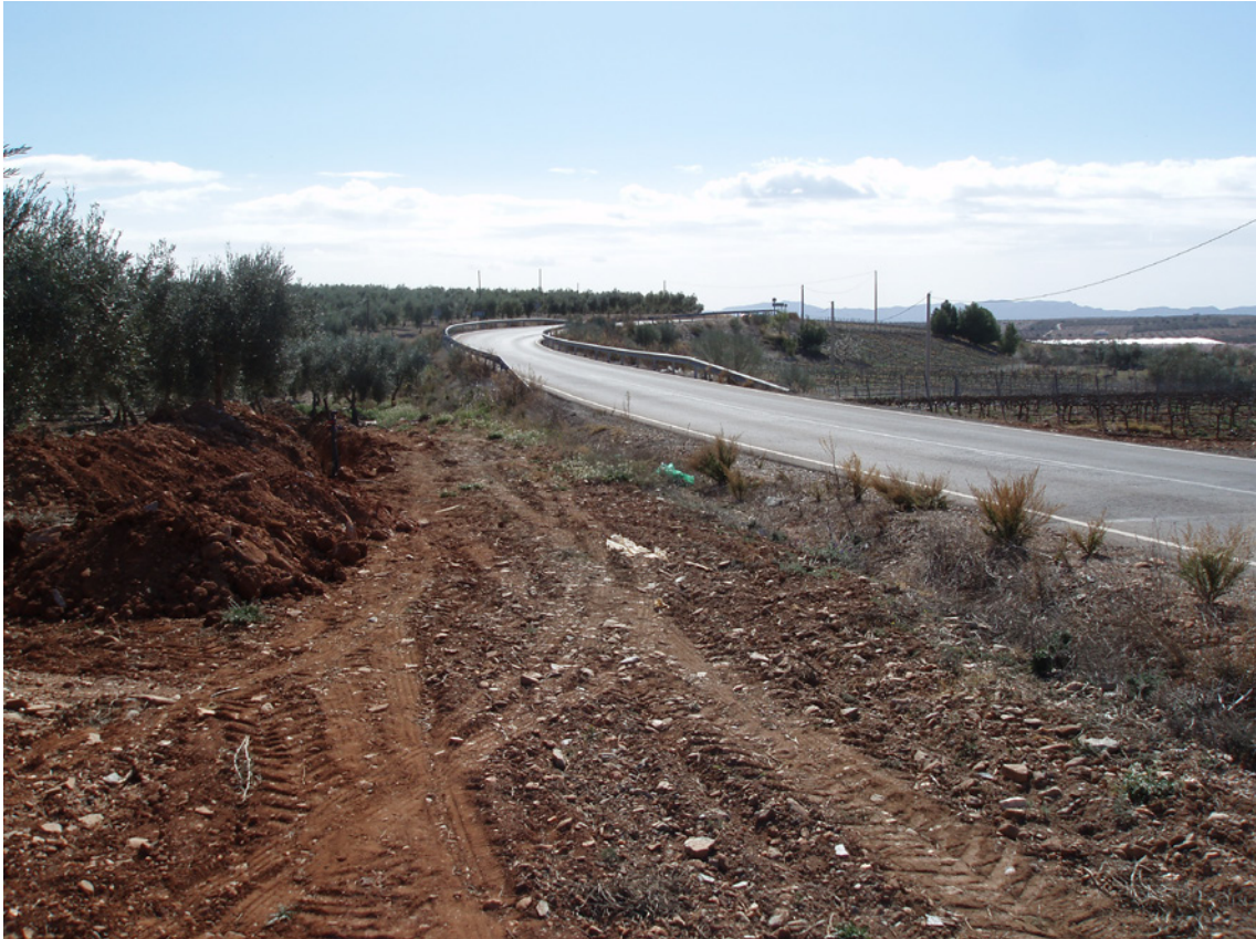
Lámina 4. Vista de la margen izquierda de la AL-4101 (PK 1+200).
