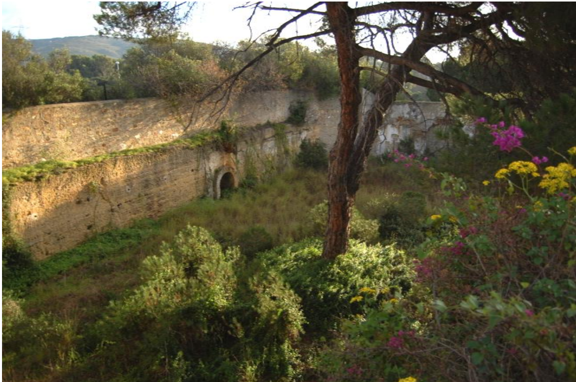
Lámina 5. Vista del interior del cortijo.
