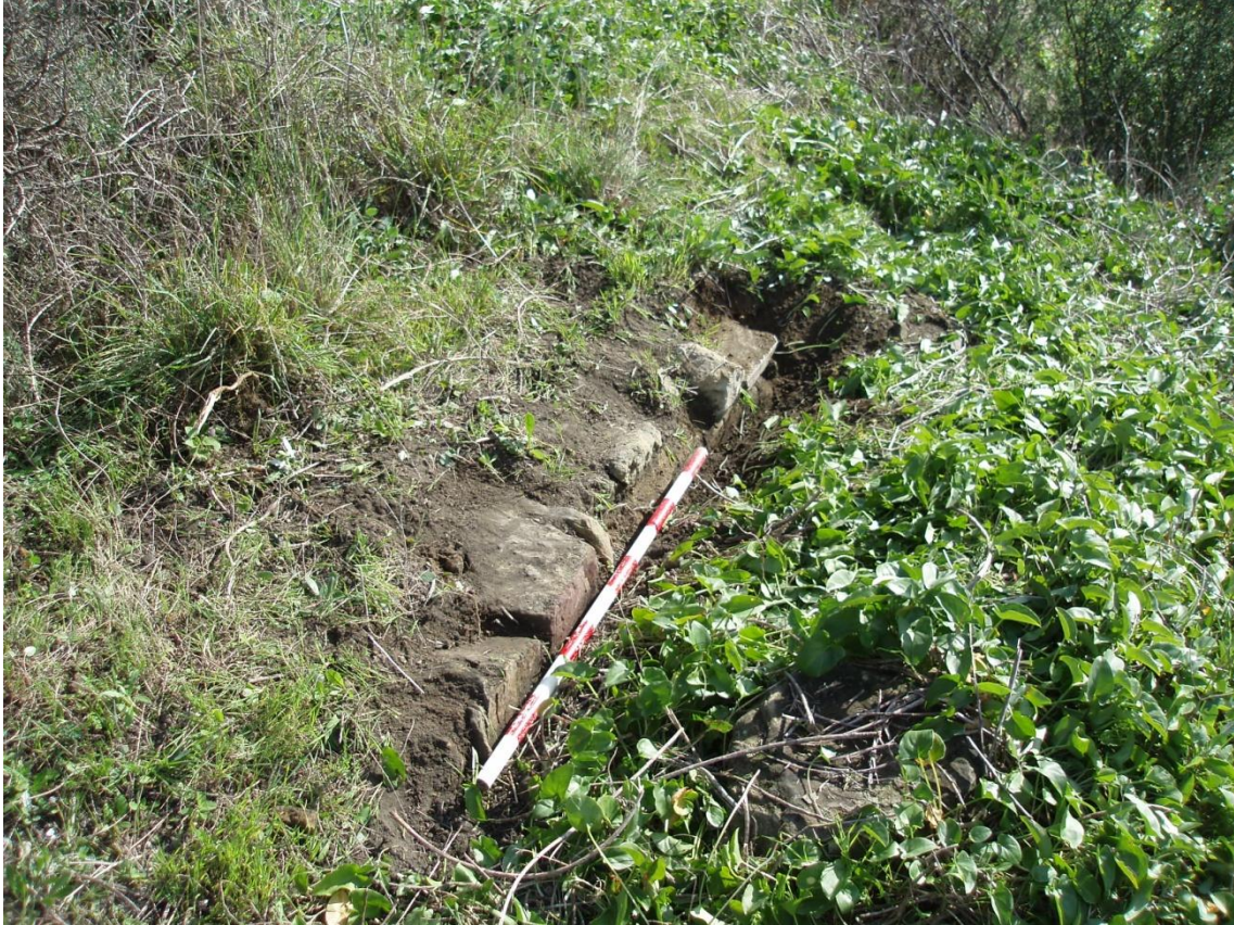
Lámina 1. Vista del muro de mampostería.
