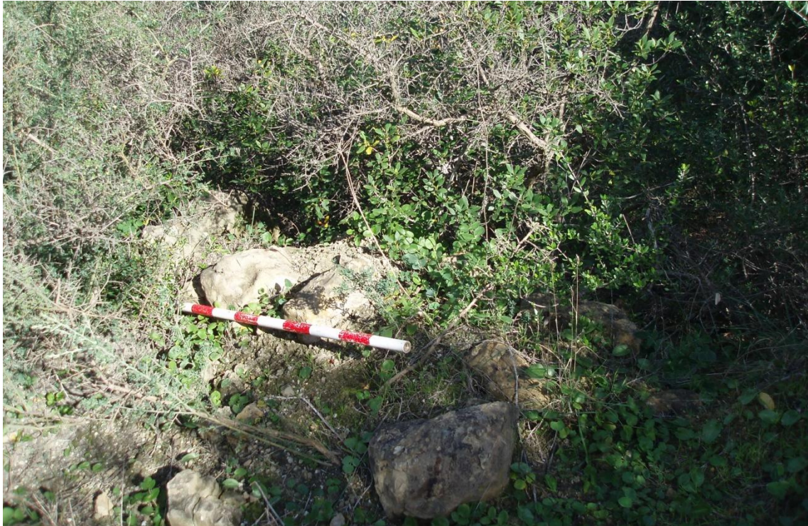
Lámina 3. Vista de la tercera estructura de mampostería.
